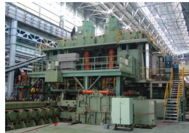
轧钢机驱动 Rolling Mill Drive
